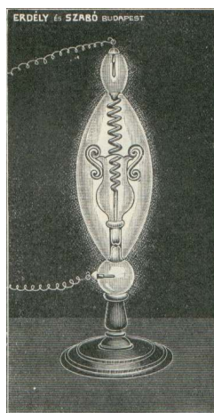
29. ábra: Színezett üvegből készült, spirális alakú Geissler-cső 1900.
