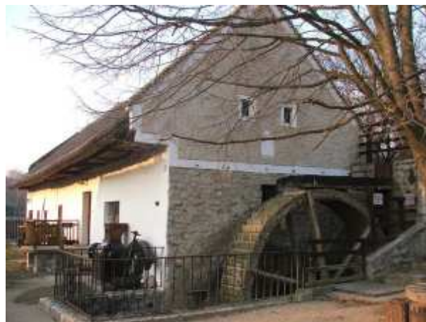
80. ábra. Az örvényesi felső-vízimalom
