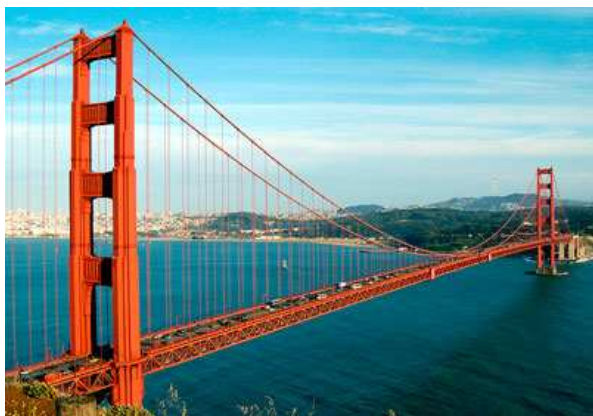
29. ábra. A Golden Gate-híd
