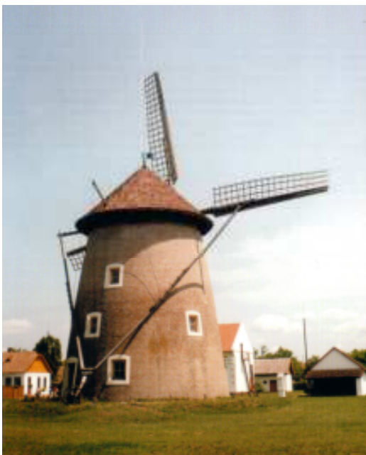
87. ábra. A szentesi szélmalom fordítórendszere
